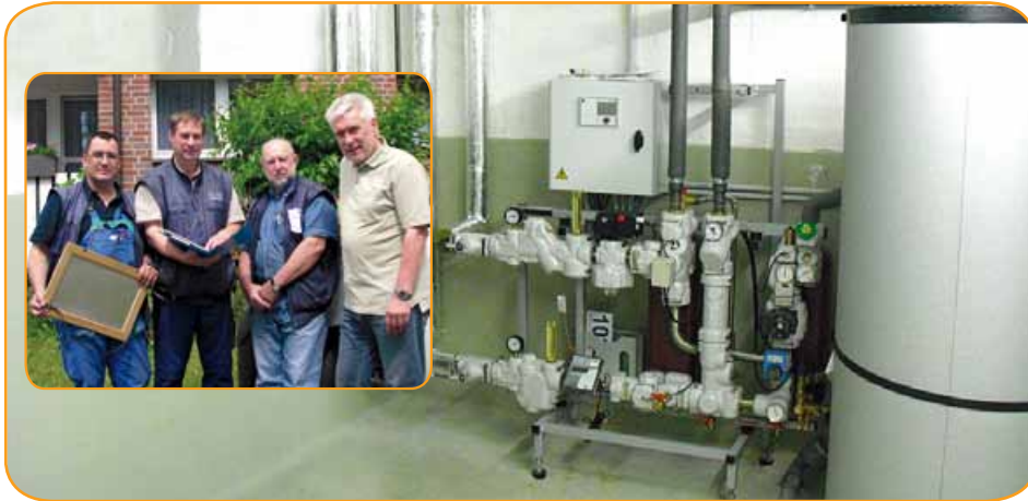
Zeit zum Umrüsten für Hans-Jürgen Pfeiffer (r.) und sein Hauswart-Team (kl. Foto). Die bisherigen Heizungsanlagen haben ausgedient. Dafür gibt's dann den Anschluss an die Fernwärme.
